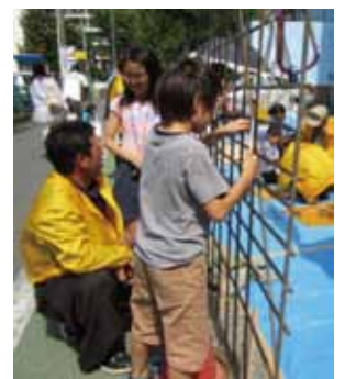
鉄筋を結ぶ作業
